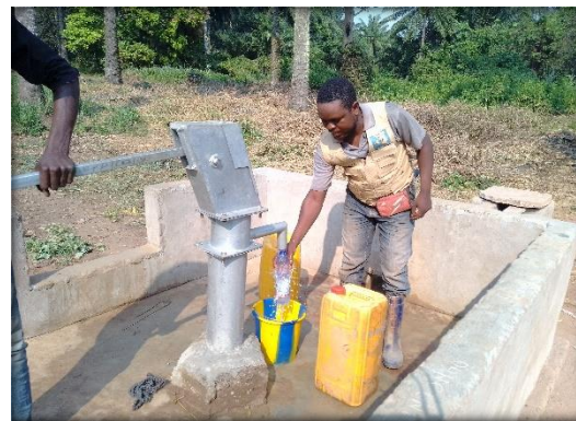
Installation de pompe du forage au Village Ewanzombo, secteur Dongo, Province du Sud Ubangi
